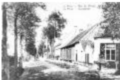
Baron de Giey laan, hoek met Kerkplein, De Pinte (I_HS_2012_024)
