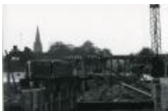
Het nieuw gemeentehuis van De Pinte in aanbouw (DP_GBS_MVDA_2015_GBDP041)
