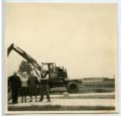
De aanleg van verkaveling Sneyersput (DP_ADK_MVDA_2015_007)
