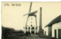
De Zwartegatmolen (DP_R_MC_MVDA_2017_stenen graan-en oliemolen De Pinte)
