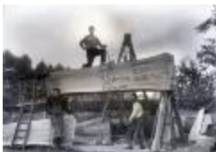
Zevegense houthandel/houtzagerij (N_2014_JV_EL372)
