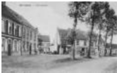
Dorpplaats, Zevergem (I_HS_2012_013)
